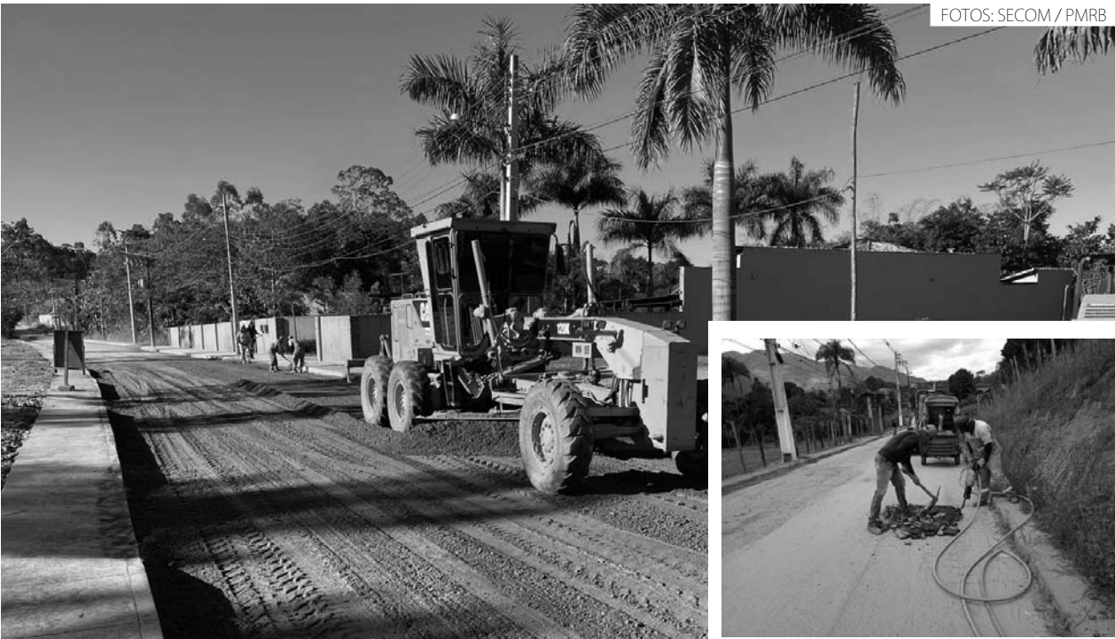
Etapas da pavimentação que acontece nos bairros Viçosa (foto em destaque) e Cajueiro (no detalhe)
