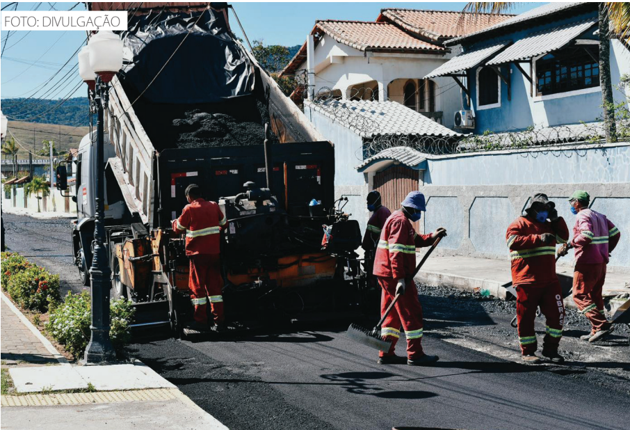
Nesta fase, o SOMAR asfaltou as ruas 10 e 11 do distrito de Ponta Negra
